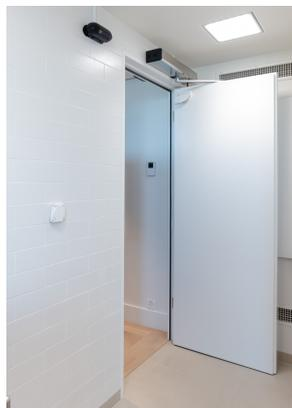
Zur Öffnung der Drehflügeltür reicht die bloße Annäherung der Hand an den berührungslosen Auslösetaster. Dadurch wird der Kontakt zum Türdrücker beim Passieren der Tür vollständig vermieden.
