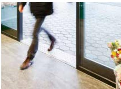
Bei Natursteinböden kommen häufig Abweichungen in der horizontalen Ebene zustande. Um die Freigängigkeit der Türflügel sicherzustellen, ist der Einbau einer Bodenschiene die beste und gleichzeitig auch die eleganteste Lösung. Die Abdichtung der Türunterkante wird zwangsläufig verbessert, da nicht auf schlechte Bodenbeschaffenheit oder Niveaufehler Rücksicht genommen werden muss.
